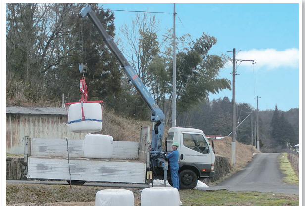
積み込み作業
